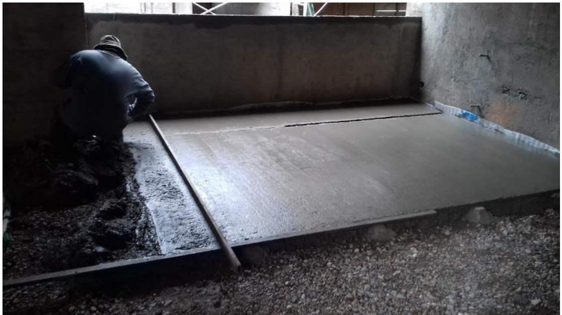
Figura 16: alisado del contrapiso
