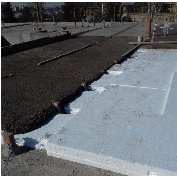
Figura 2: Materialización de contrapisos aliviados
