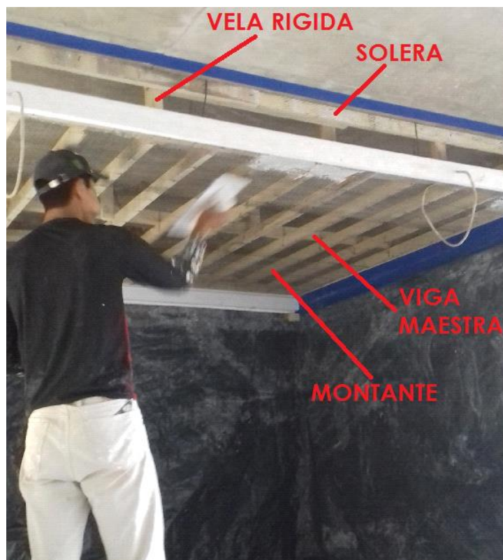
Figura 12: cielorraso suspendido
