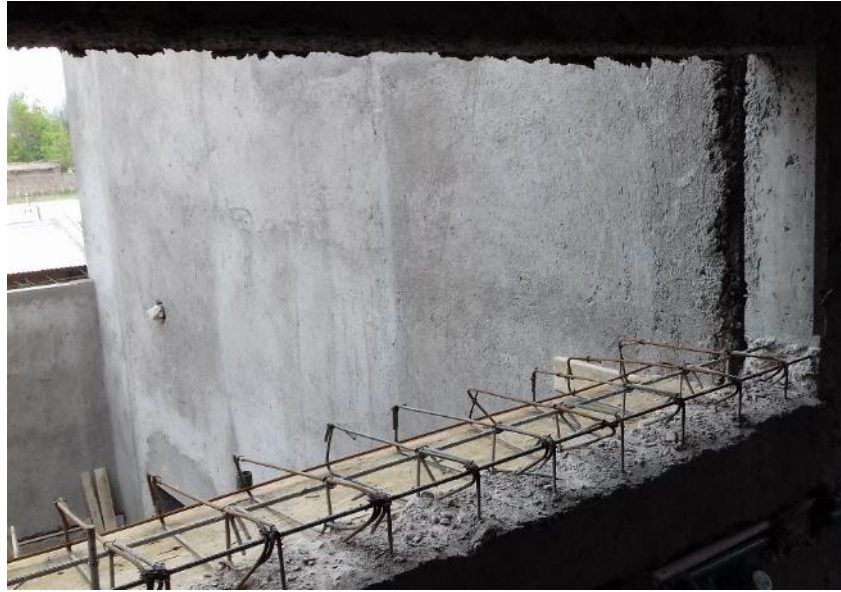
Figura 26: alero resuelto en la etapa de revoques
