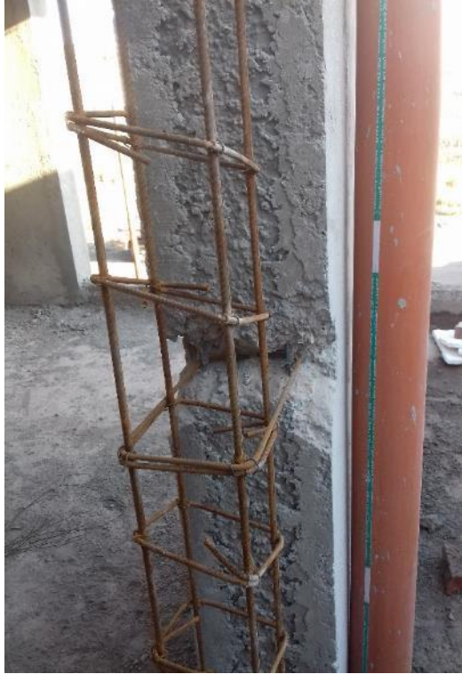
Figura 21: ensanche de columna
