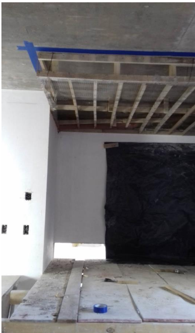
Figura 10: tareas previas a la aplicación de yeso
