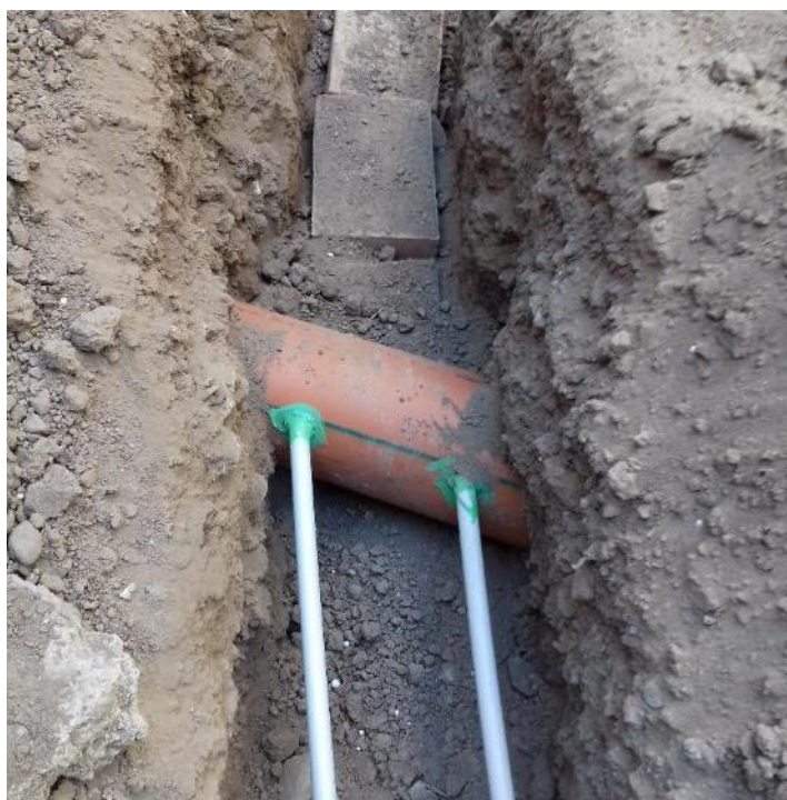
Figura 30: conexión desagüe A/C - pluvial
