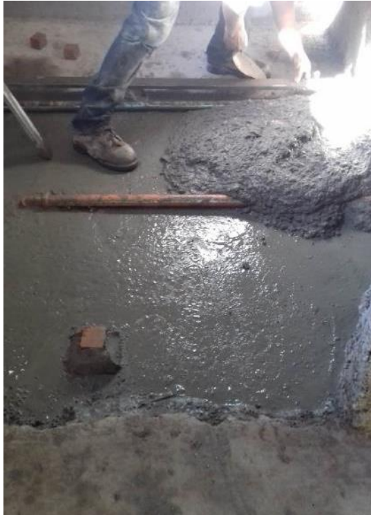
Figura 15: lechada y llenado de contrapisos de planta alta
