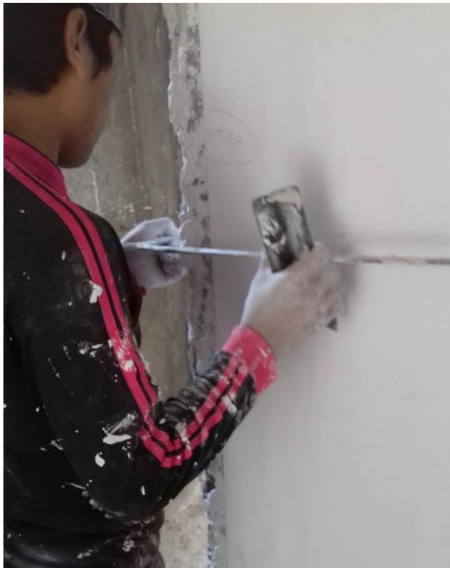
Figura 11: verificación de escuadra
