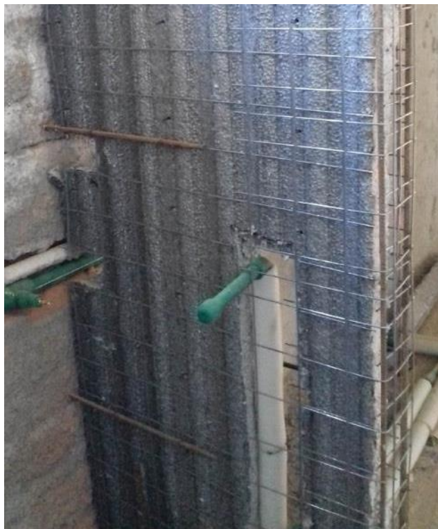
Figura 19: instalaciones en Sistema Cassaforma
