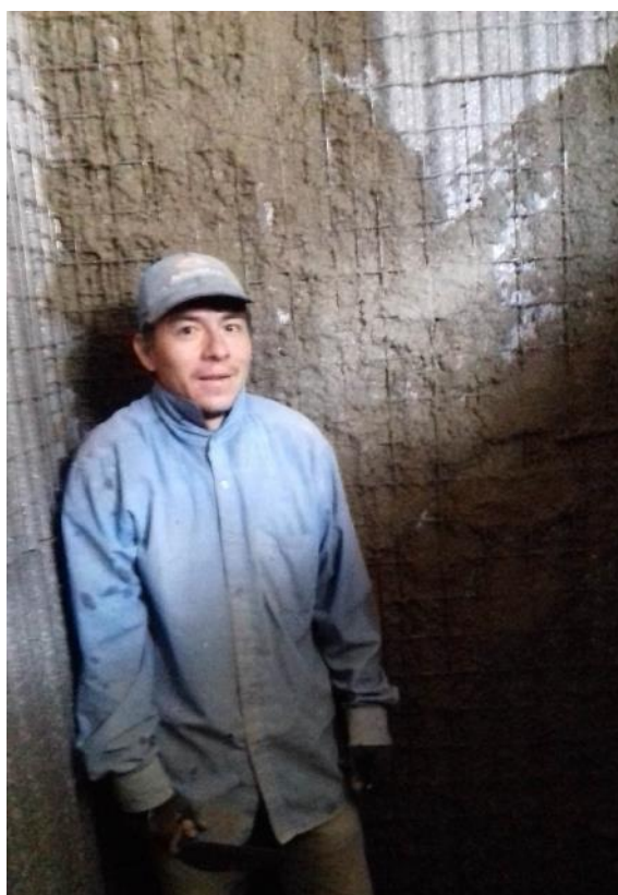
Figura 6: Chicoteado de muros Casaforma
