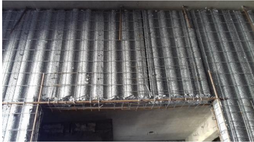
Figura 20: dinteles reforzados en Sistema Cassaforma
