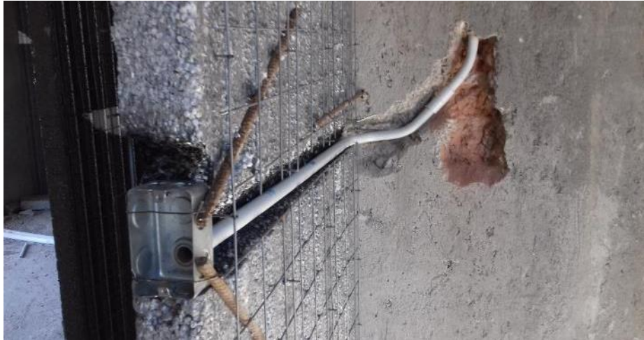
Figura 28: cambio de lugar de bocas de luz
