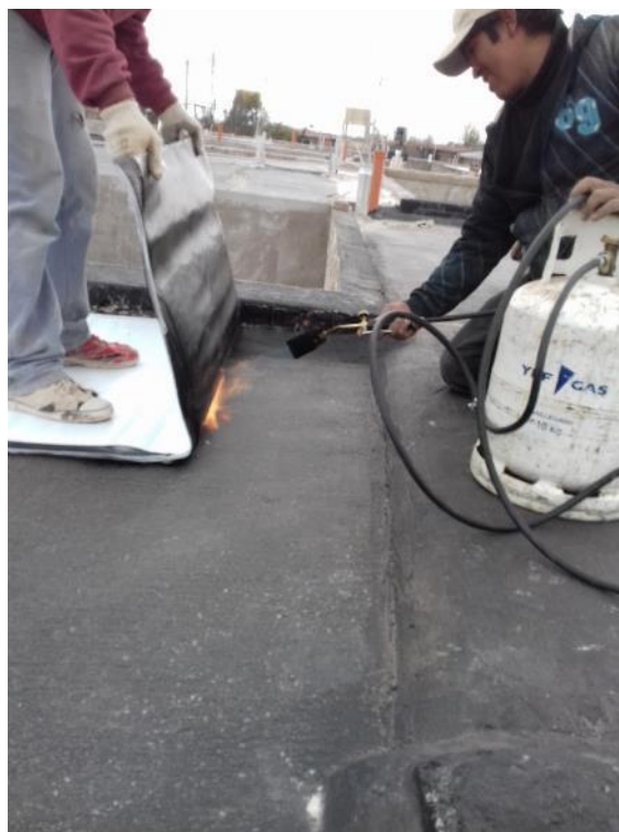
Figura 4: Colocación de membranas
