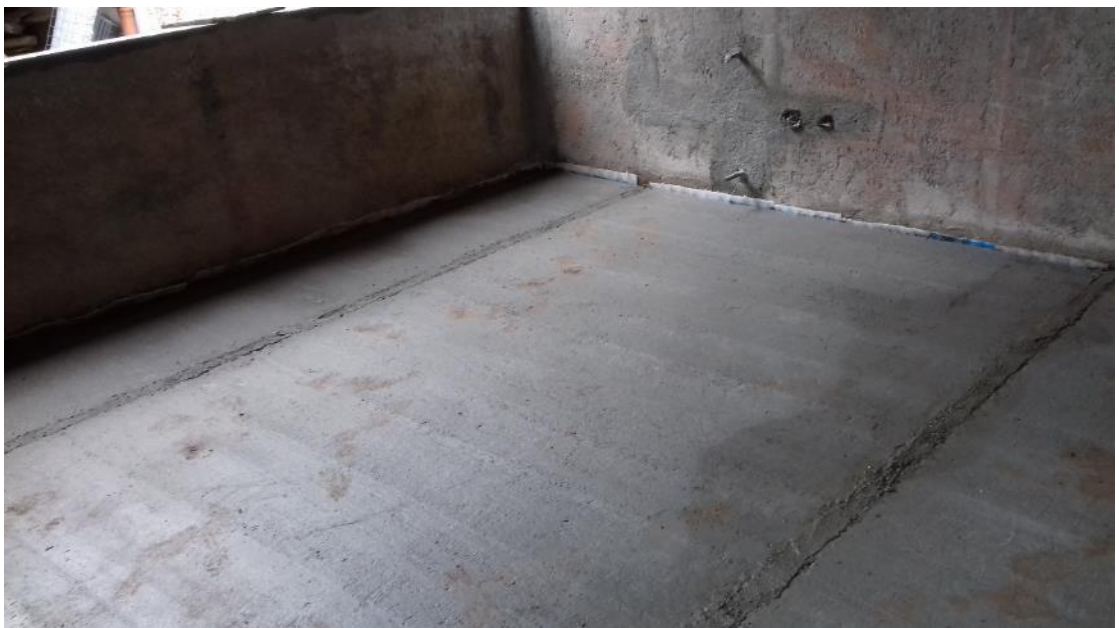
Figura 18: llenado de espacios con mortero
