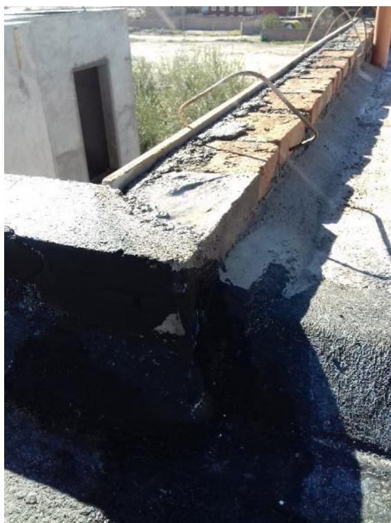
Figura 3: Ejecución de babetas
