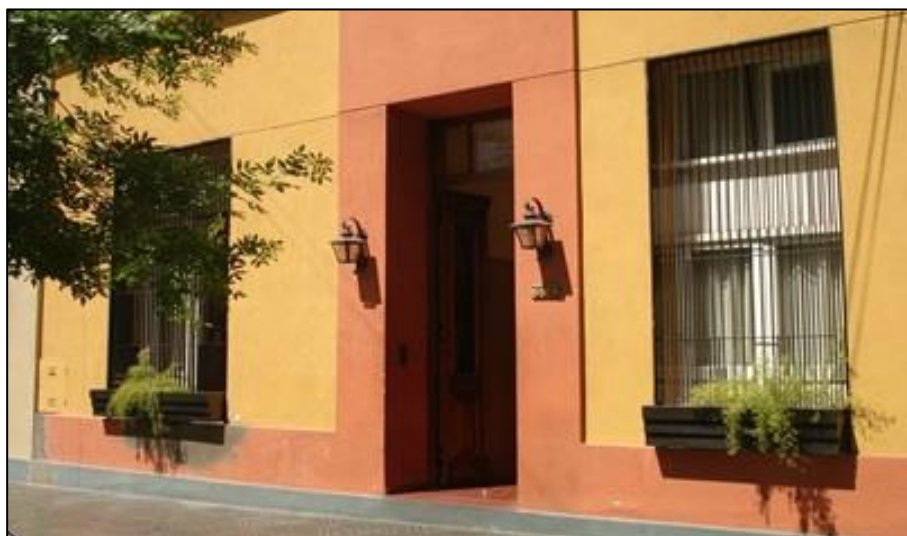
Fotografía N°3: Vista de la Residencia Universitaria Mendoza
