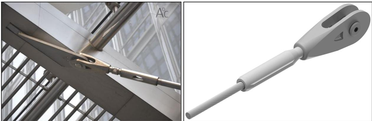
*Figura 45. Elemento de conexión de tensor a pletina*
