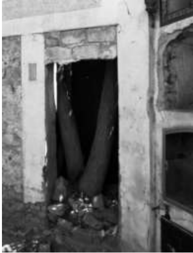
Imagen 5_ Cementerio de Ciudad, área antigua. Puerta de ingreso clausurada, puesta sobre la intersección de las calles San Martín y Caseros. Fotografía de autor.
