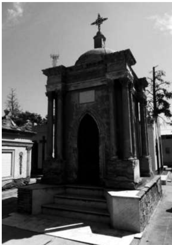
Cementerio de Ciudad, área antigua, cuadro D. Isabel de Mernis, 1895. Fotografía de autor.
