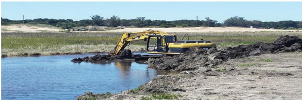
Figura 9. Obras en el mega emprendimiento “La Mansa” en Gral. Madariaga. Se organiza entorno a una laguna artificial. En este caso se observa la obra en proceso, la misma revaloriza las propiedades frentistas, al tiempo que extrae material para elevar cotas de altura del terreno. Fuente: <http://www.lamansagreencity.com/obra.html>
