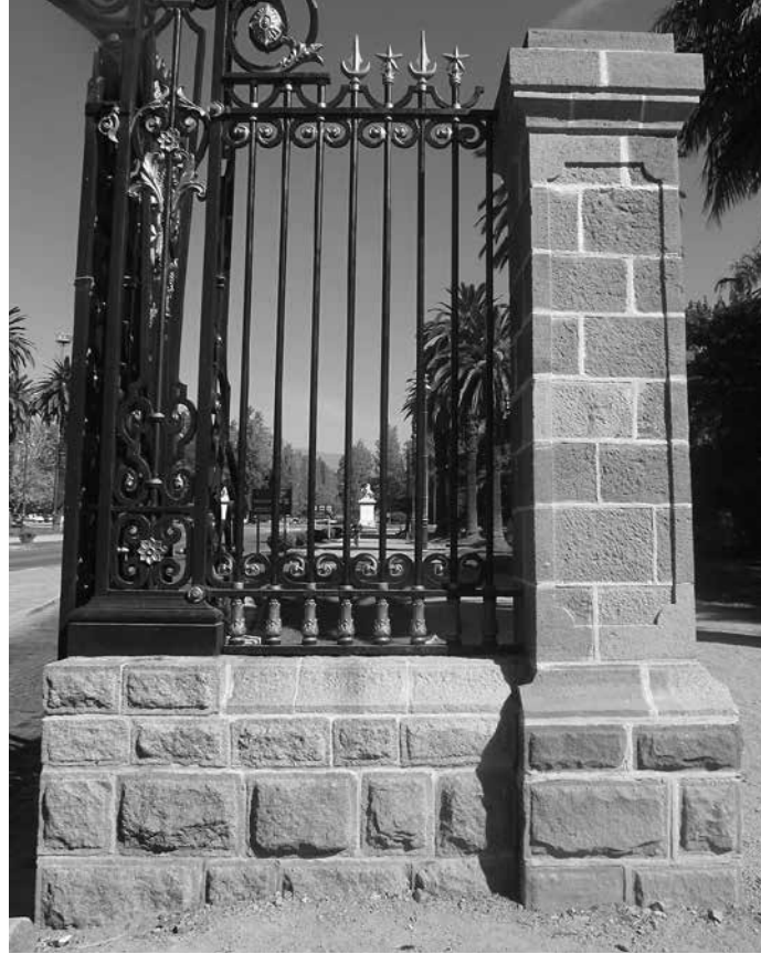
72. Sección de rejas existentes de la Fundición Berri (Foto actual).
