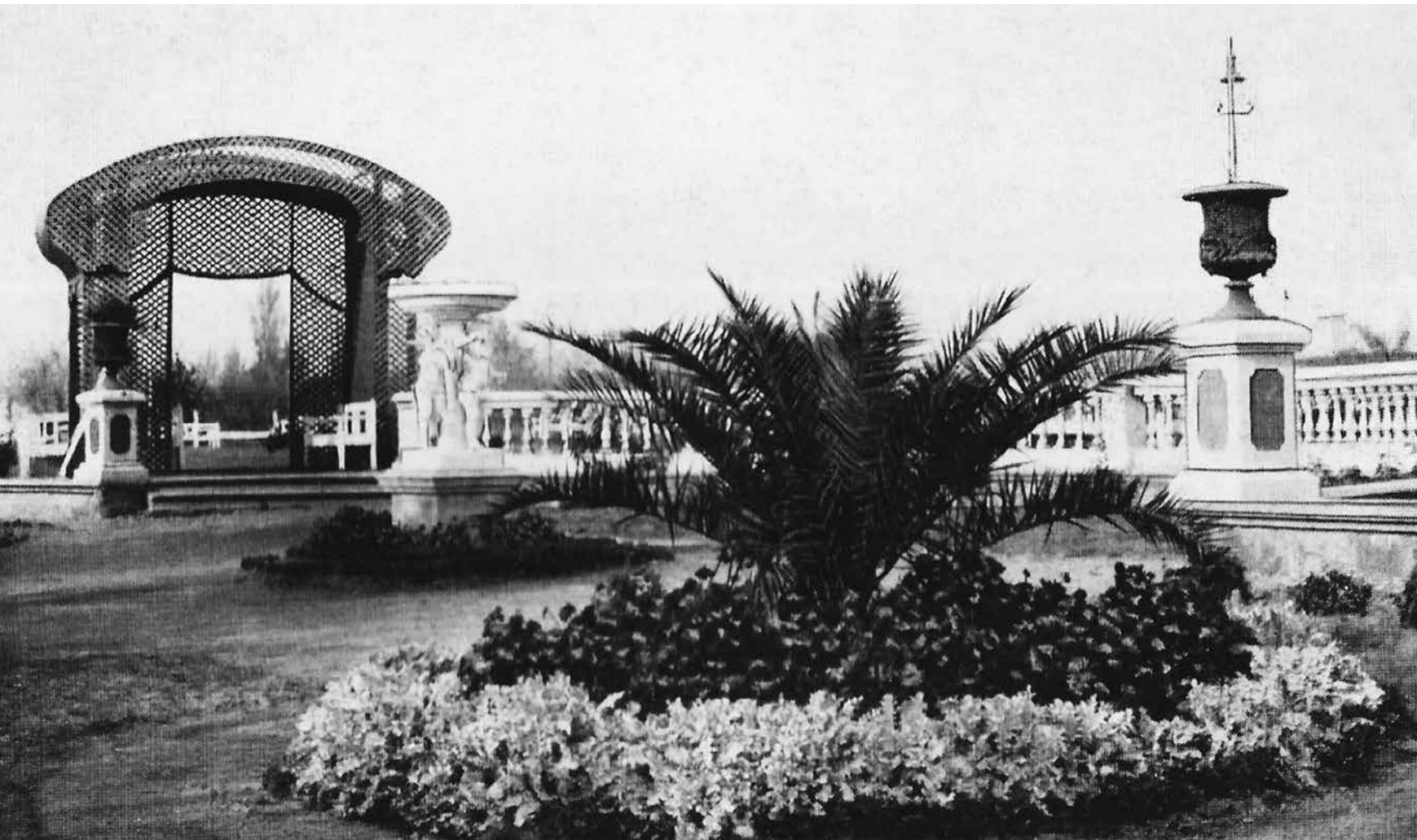
177. Vista del sector central del Rosedal. Se aprecia un trillage, una fuente y vasos sobre pedestales (Postal antigua, Birle).
