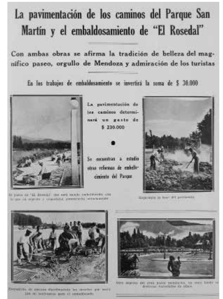
236. Obras realizadas en el Parque con antelación al Plan Regulador: cambio de luminaria y embalsosamiento del Rosedal, 1938 (Q. Social).
