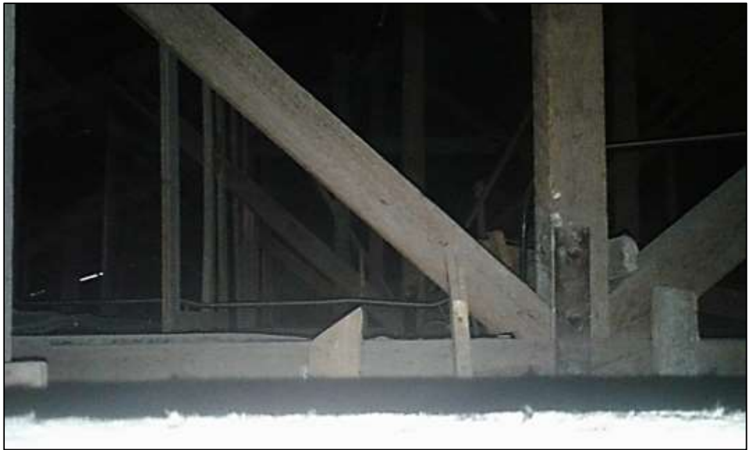
Fig. 17 Estado de las Vigas Reticuladas de madera de la Cubierta
