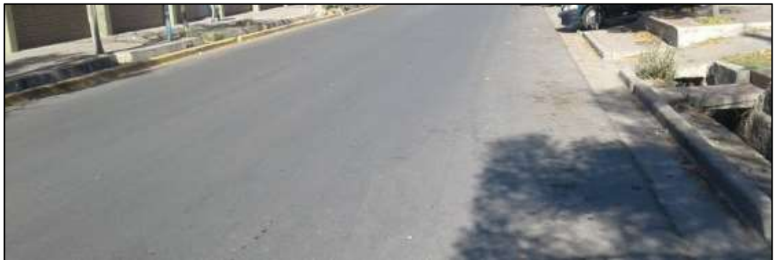
Fig. 36 Estado actual de la Calle Chuquisaca
