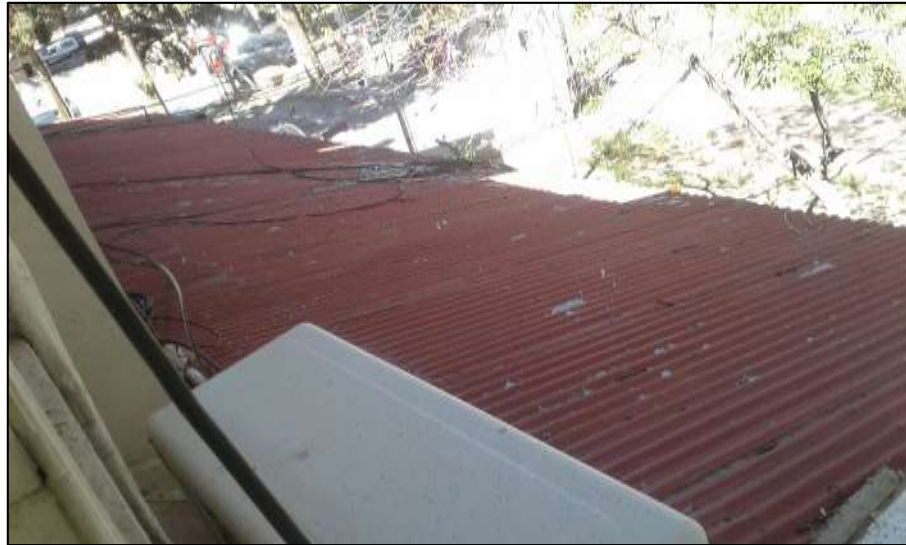
Fig. 21 Estado de la Chapa de la Galería vista desde Planta Alta
