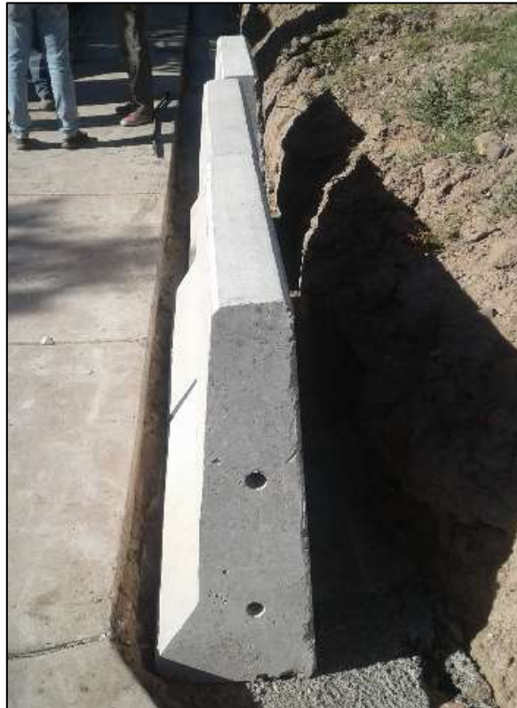
Fig. 44 New Jerseys siendo colocados al costado de la Ciclovía El Jarillal
