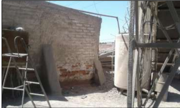
Fig. 28 Lugar para ubicar el nuevo tanque de la planta
