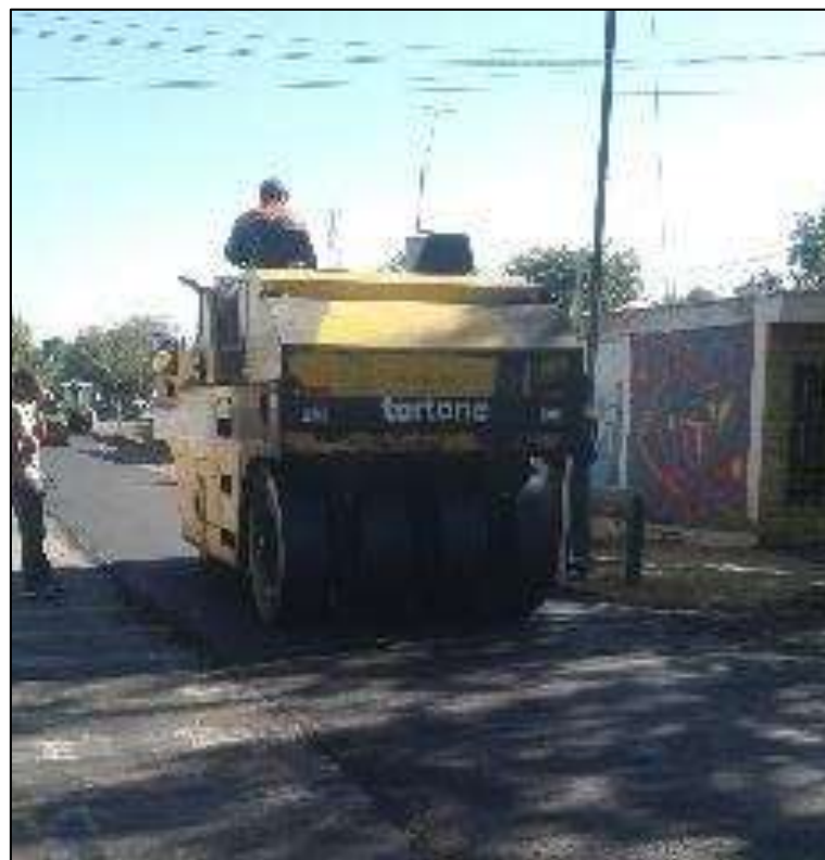
Fig. 47 Aplanadora de Rodillo Liso realizando carpeta asfáltica
