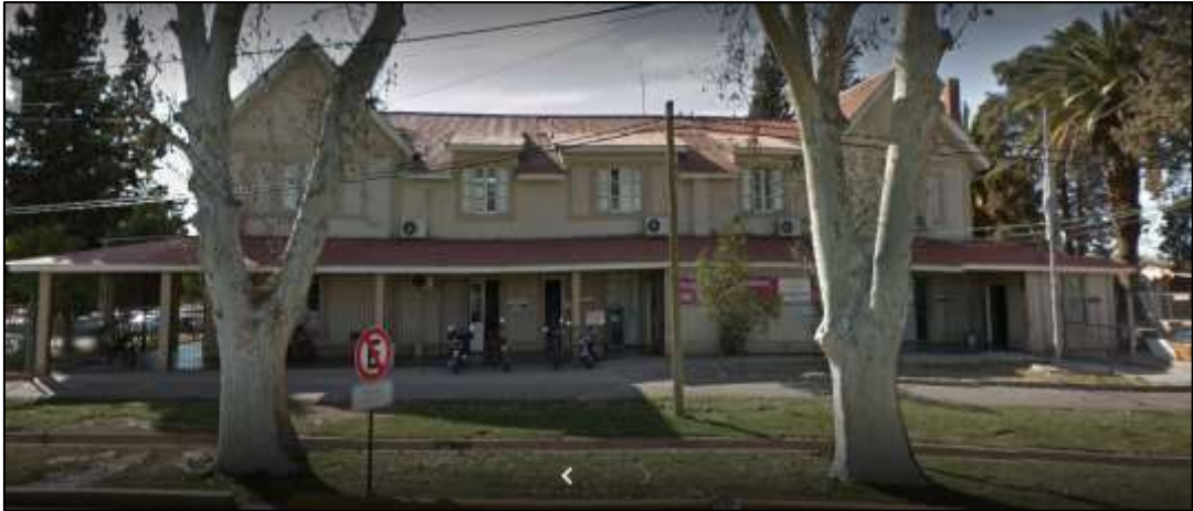
Fig. 14 Fachada Oeste Juzgados de tránsito
