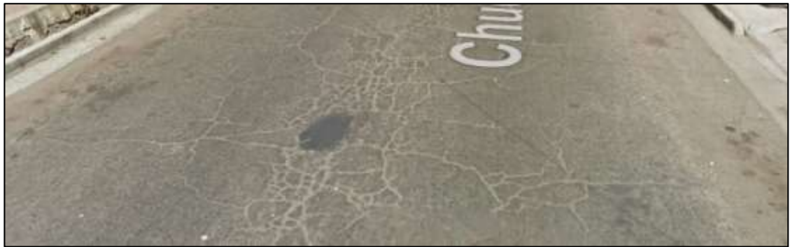
Fig. 35 Estado de la Calle Chuquisaca antes de ser asfaltada nuevamente
