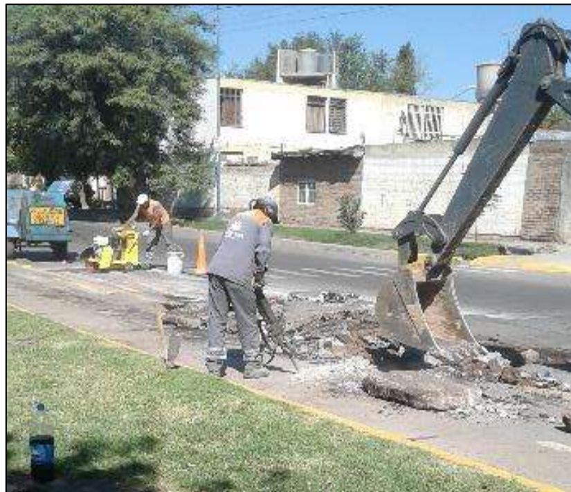
Fig. 45 Rotura para reparación con martillo neumático y retroexcavadora
