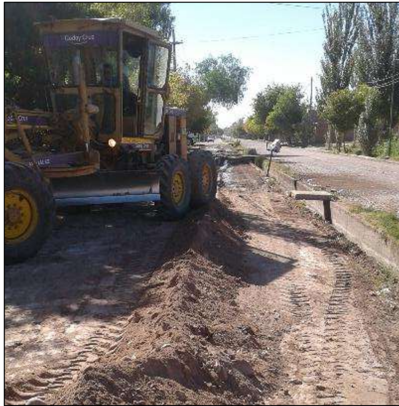
Fig. 46 Motoniveladora preparando capa granular para una carpeta asfáltica
