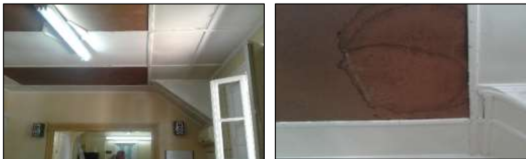
Fig. 22 Estado de Cielorraso de Planta Alta
