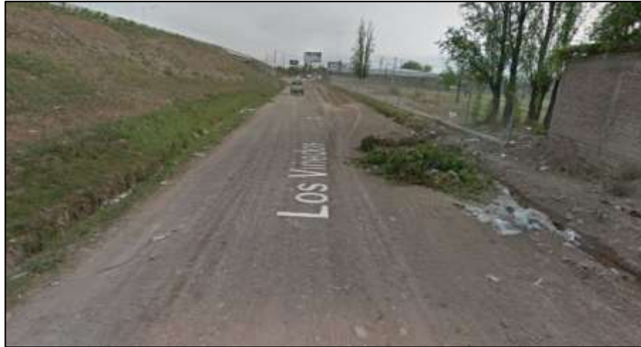
Fig. 7 Calle Los viñedos - Calzada de Terreno Granular
