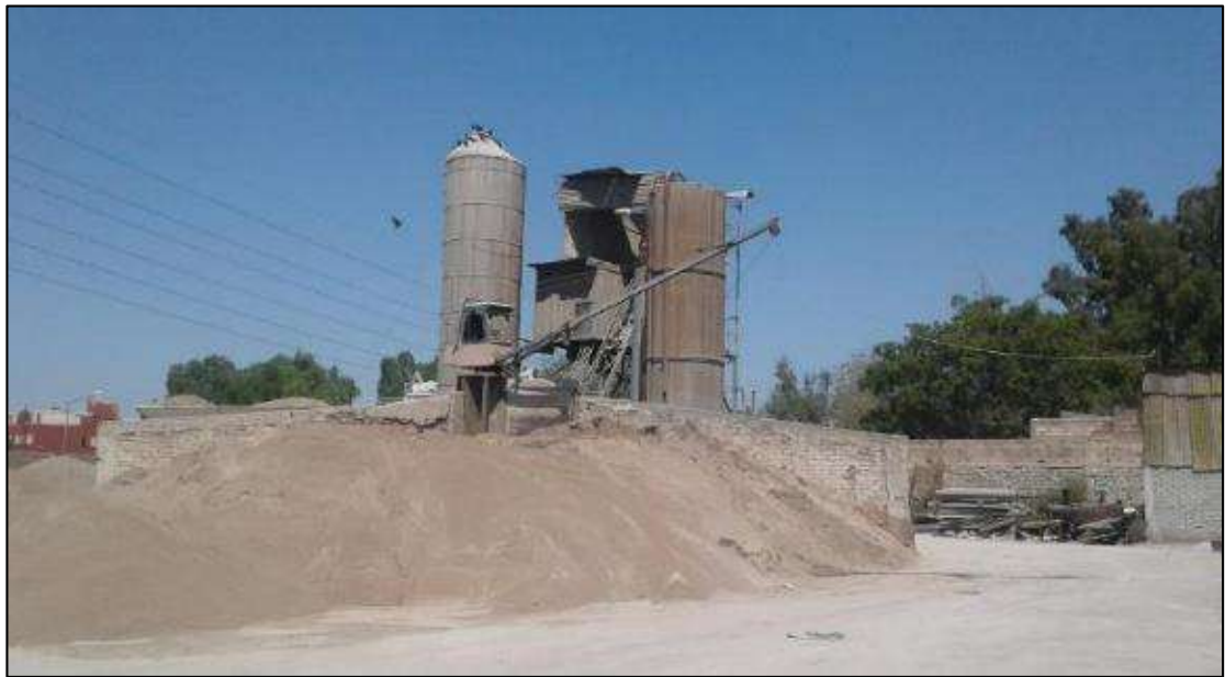
Fig. 27 Vista General de la Planta Hormigonera del Corralón
