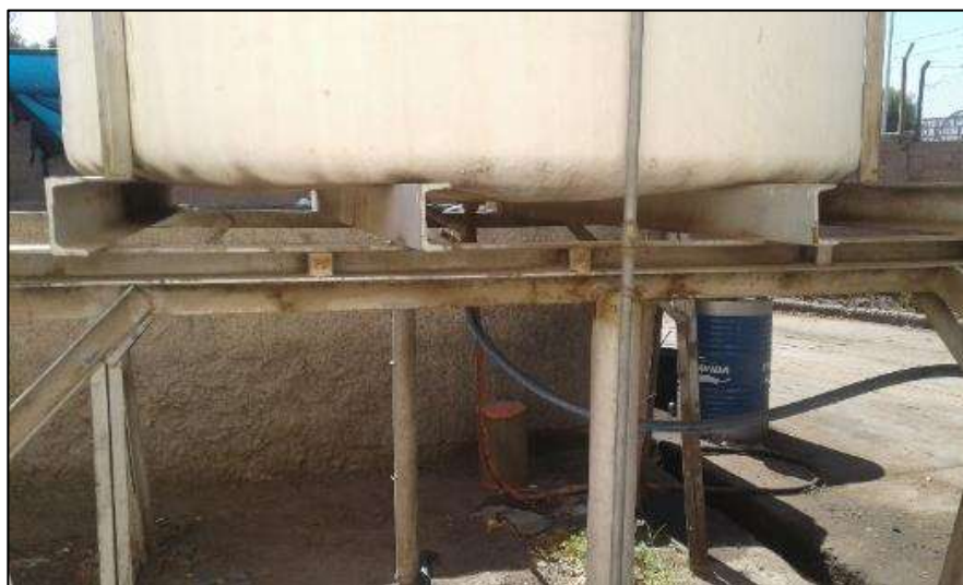
Fig. 30 Vista de la sección transversal de los perfiles utilizados
